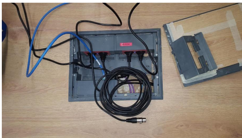
Figura 11 – Cableado de micrófono en sala de vistas
